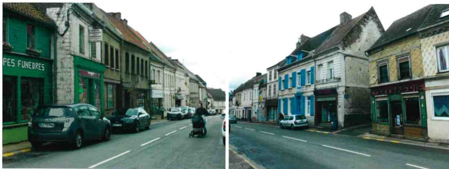
D'autres façades qui nuisent particulièrement à l'impression générale.
